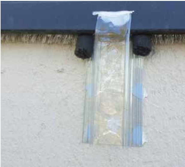
Exclusion flap geplaatst onder waterslag
