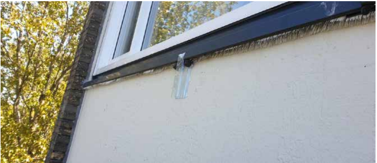
Exclusion flap geplaatst onder waterslag
