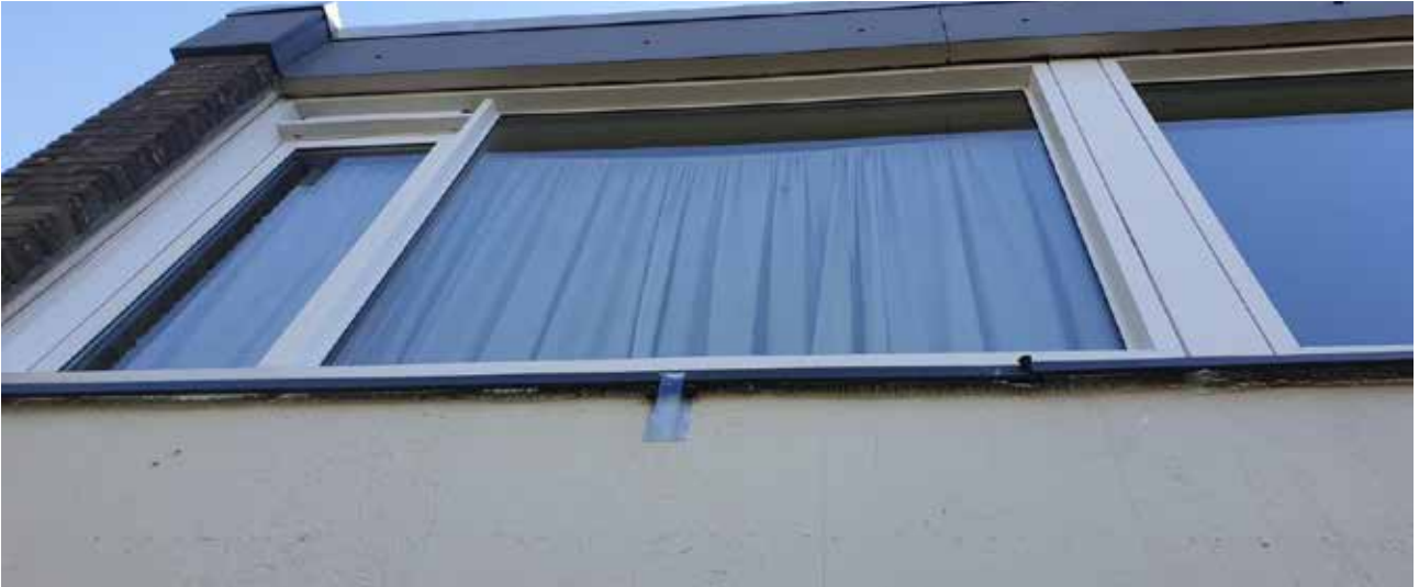
Exclusion flap geplaatst onder waterslag
