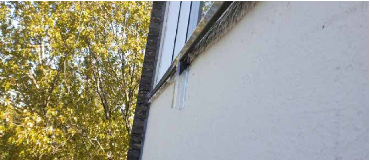
Exclusion flap geplaatst onder waterslag
