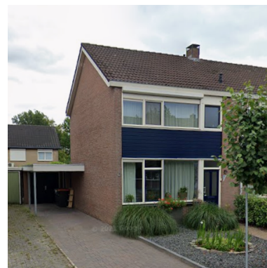
Figuur 1: voorbeeld van een bemonsterde kopgevel in Tubbergen.
